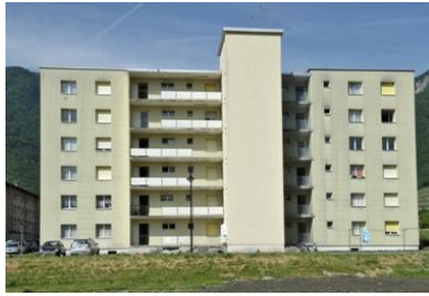
23 VS, Vouvry Rue du Vieux Port 5-7 Verkehrswert: 9'004'000 / Whg. 45 / KF –
