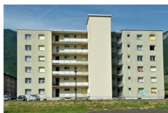
VS, Vouvry 31 Rue du Vieux-Port 5/7 Verkehrswert: 9'662'000 / Whg. 39 / KF -
