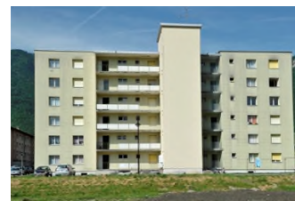
VS, Vouvry 33 Rue du Vieux-Port 5/7 Verkehrswert: 9'662'000 / Whg. 45 / KF -
