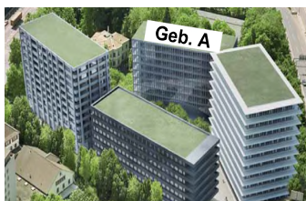
BS, Bâle 45 City-Gate Baufeld A, St. Jakobs-Strasse Valeur vénale: MCHF 21.246 / App. 117 / SC 3
