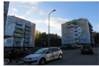
GE, Versoix 18 Chemin de l'Ancien Péage 2/4 Valeur vénale: MCHF 23.670 / App. 70 / SC 3
