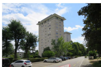
AG, Spreitenbach 4 Poststrasse 180 Valeur vénale: MCHF 13.150 / App. 49 / SC -
