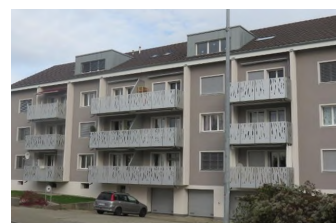
AG, Oberrohrdorf 3 Badenerstrasse 6/8/10/12 Valeur vénale: MCHF 9.619 / App. 32 / SC -
