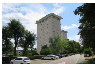
AG, Spreitenbach 4 Poststrasse 180 Valeur vénale: 12'300'000 / App. 49 / SC -
