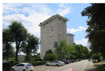
AG, Spreitenbach 4 Poststrasse 180 Valeur vénale: 12'120'000 / App. 49 / SC -
