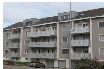
AG, Oberrohrdorf 3 Badenerstrasse 6/8/10/12 Valeur vénale: 8'940'000 / App. 36 / SC -
