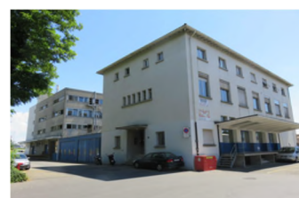
VD, Lausanne-Malley 43 Rue du Grand-Pré 8/10 Valeur vénale: 11'400'000 / App. 2 / SC 14
