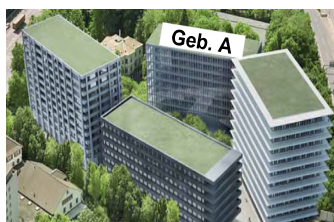
BS, Bâle 54 City-Gate Baufeld A, St. Jakobs-Strasse Valeur vénale: MCHF 30.102 / App117 /SC 3
