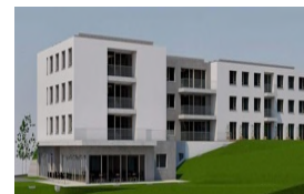
EMS avec logement protégé, Boudry (NE)
