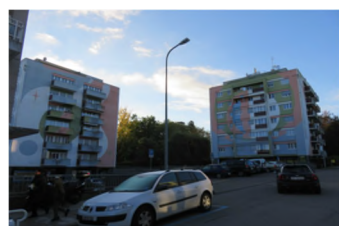
GE, Versoix 22 Chemin de l'Ancien Péage 2/4 Valeur vénale: MCHF 25.230 / App 70 / SC 3
