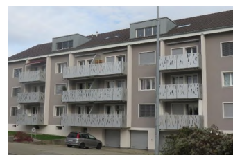
AG, Oberrohrdorf 3 Badenerstrasse 6/8/10/12 Valeur vénale: MCHF 10.030 / App 32 / SC -
