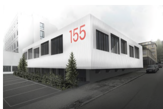
NE, La Chaux-de-Fonds Rue Jardinière 155 Valeur vénale: MCHF 5.5 Utilisation: Atelier pour personnes handicapées
