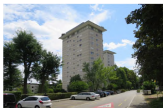
AG, Spreitenbach 4 Poststrasse 180 Valeur vénale: MCHF 12.155 / App 49 / SC -
