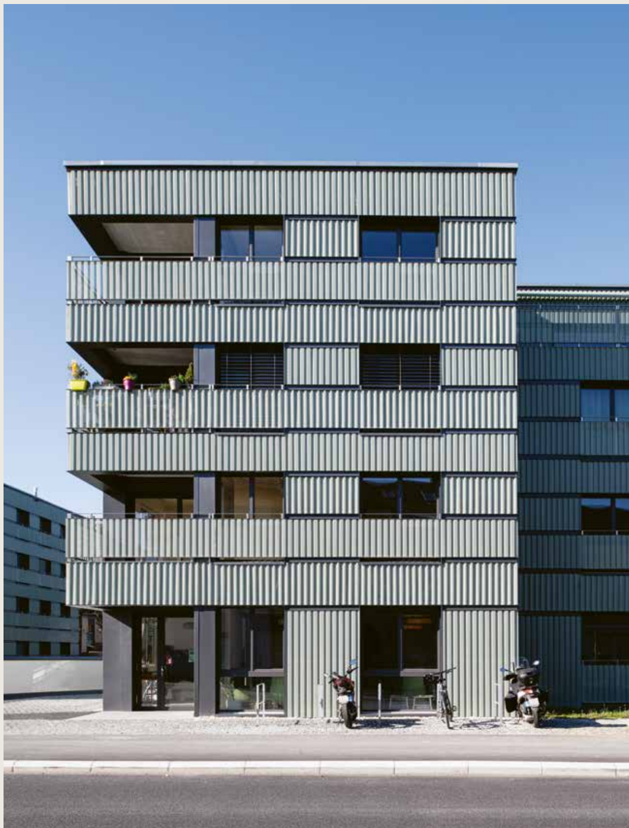
Route des Grange-Saint-Martin 1/3, Orbe
