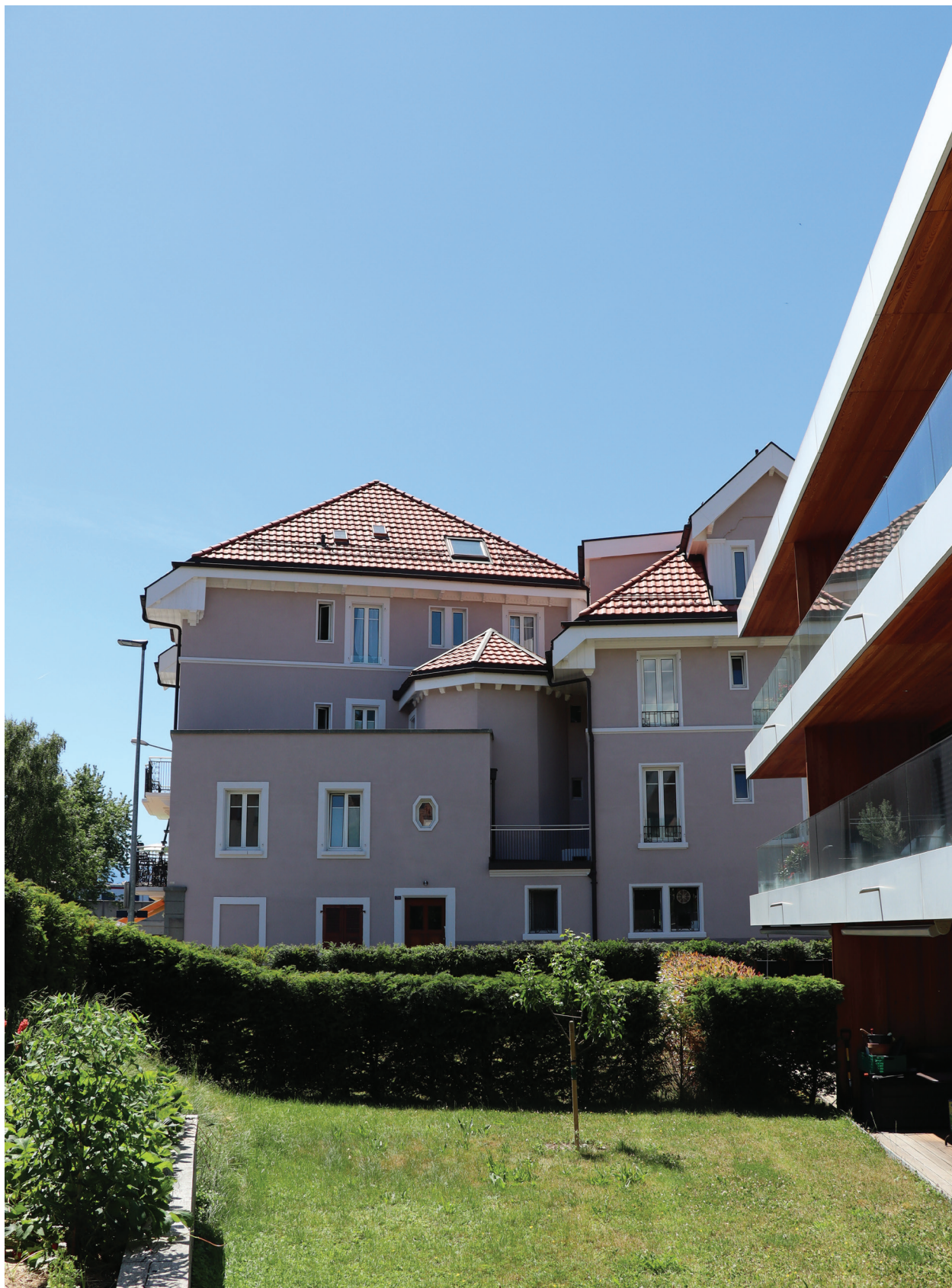
Avenue des Alpes 71-73, La Tour-de-Peilz
